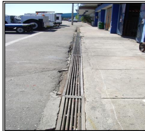
Foto. Canal de aguas lluvias con rejilla en hierro, ubicado en la parte occidental de la plataforma
