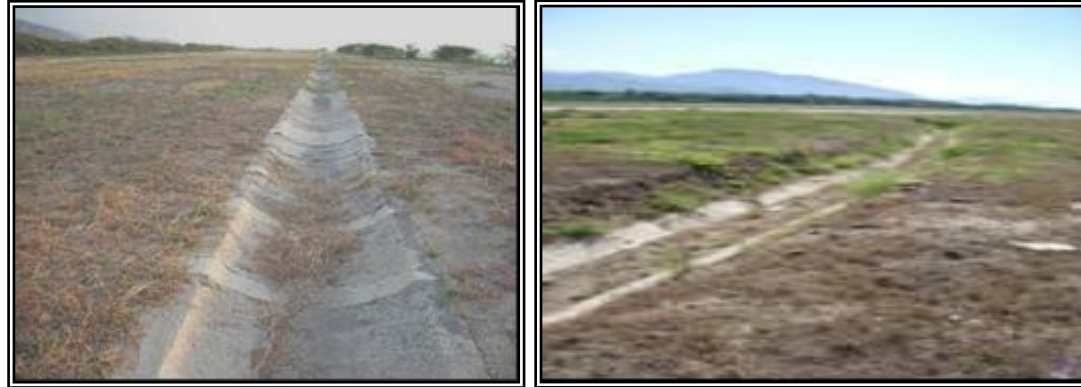
Fotos. Canales de recolección de aguas lluvias
