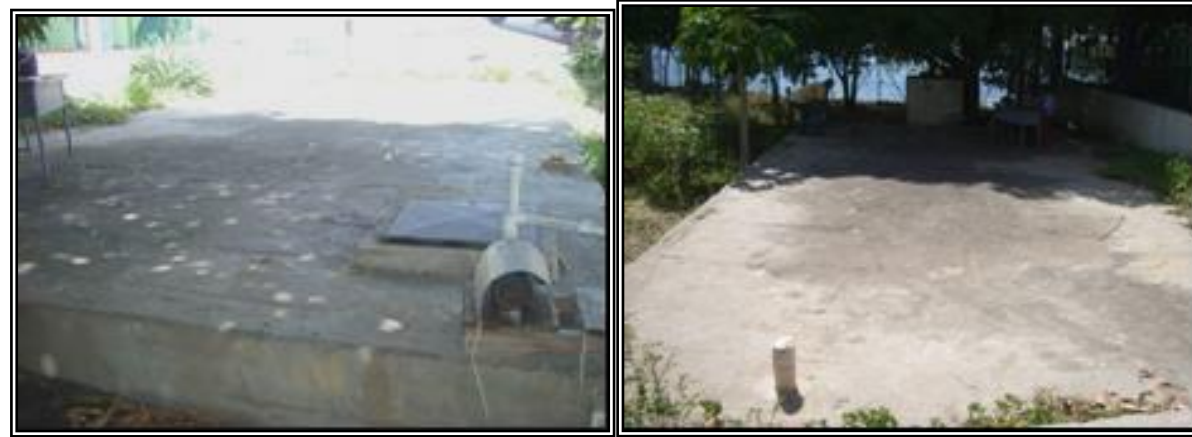
Fotos Tanque de Almacenamiento de agua potable
