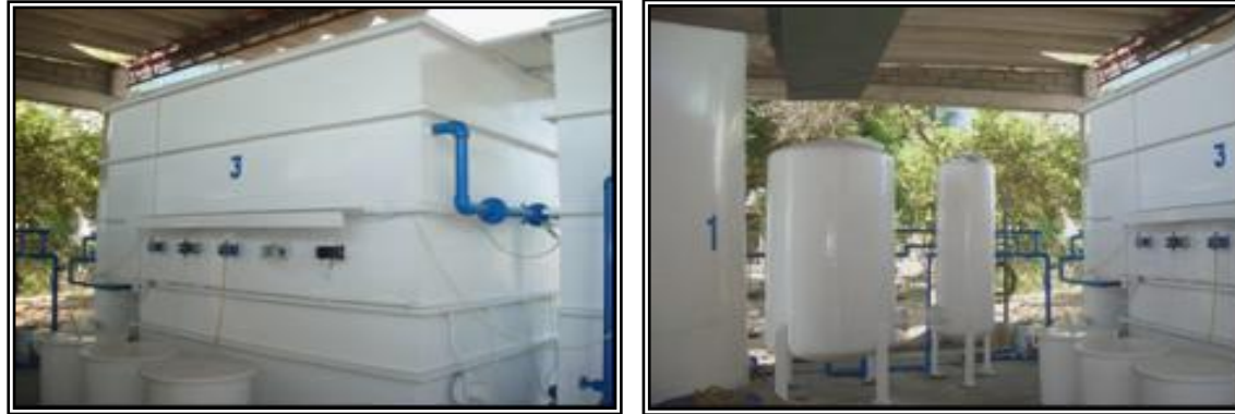
Fotos. Planta de Tratamiento de agua potable
