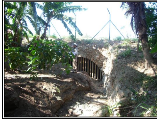
Fotos. Rejillas para conducción de aguas lluvias
