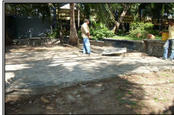
Foto. Tanque de almacenamiento de agua potable
